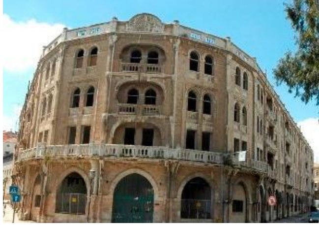
صورة 2: للمبنى بعد احتلاله من قبل إسرائيل المصدر: ( https://alquds-city.com/ )
