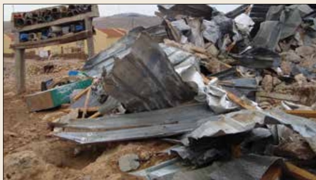
Démolition d'une maison à Um al-Kher, Cisjordanie
