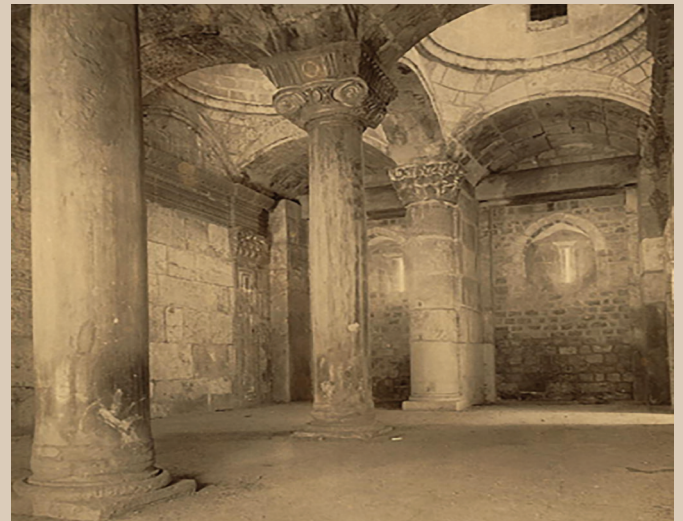
Deux piliers en pierre à l'intérieur de la Musalla de Bab Ar-Rahmé
